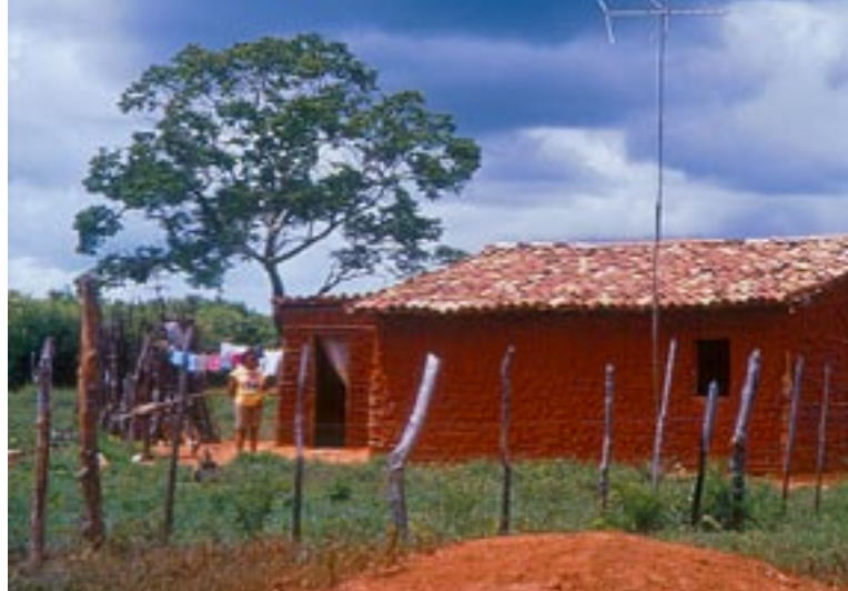
Proprietários de terras por onde passarão os canais do Projeto serão indenizados.
