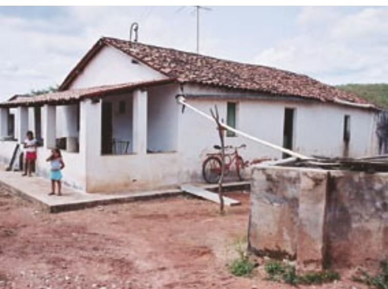
Utilização de calhas para captação da água da chuva.
