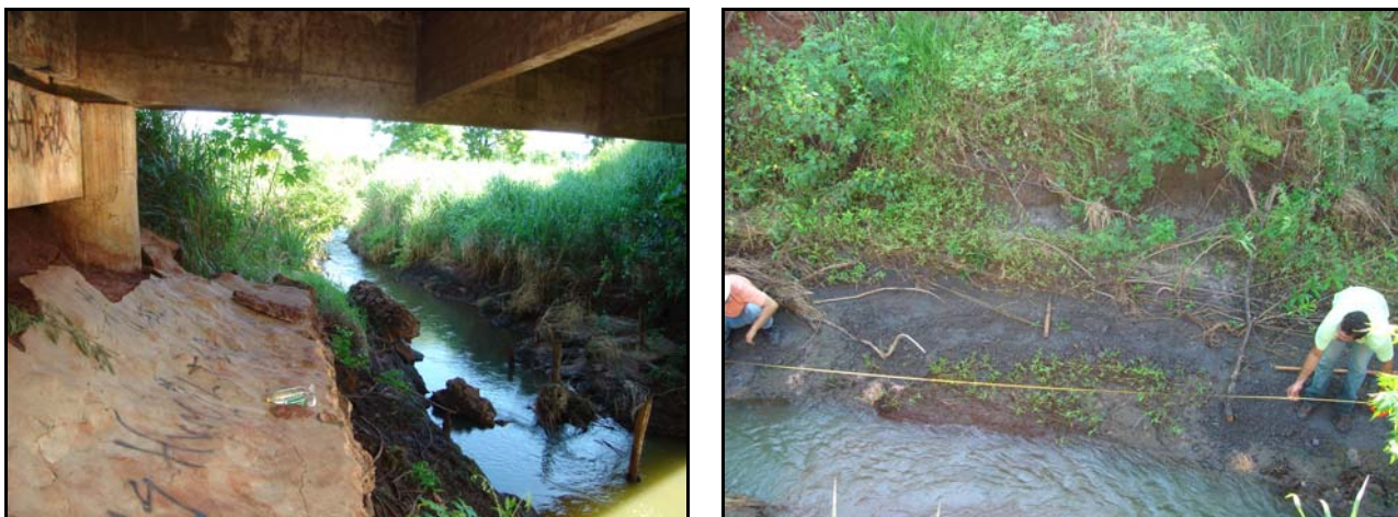
Figura 4. Ponto 3 - Rodovia de acesso de Aparecida D'oeste para Marinópolis.
