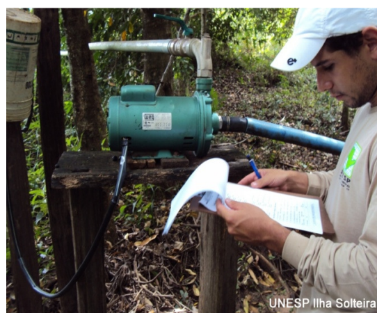
Figura 5. Anotação das características técnicas de um conjunto motobomba.
