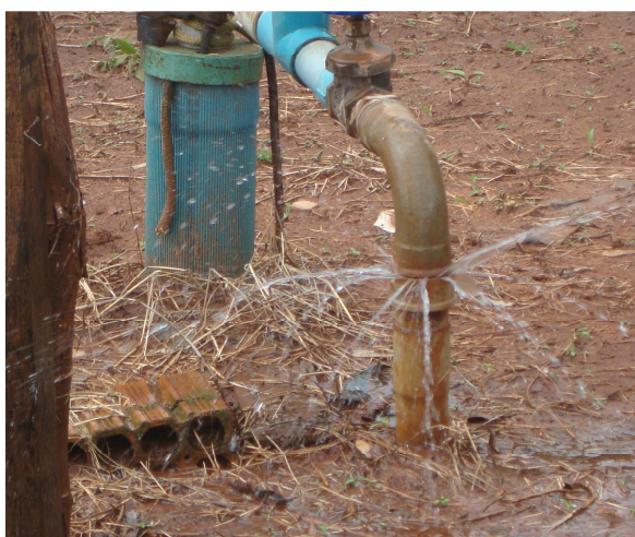
Figura 9. Vazamento na tubulação recalque.
